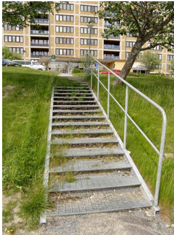
Trappa vid Sollefteå sjukhus
