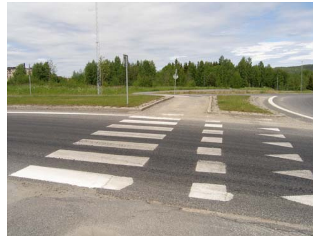
Gångpassage intill Riksväg 90
