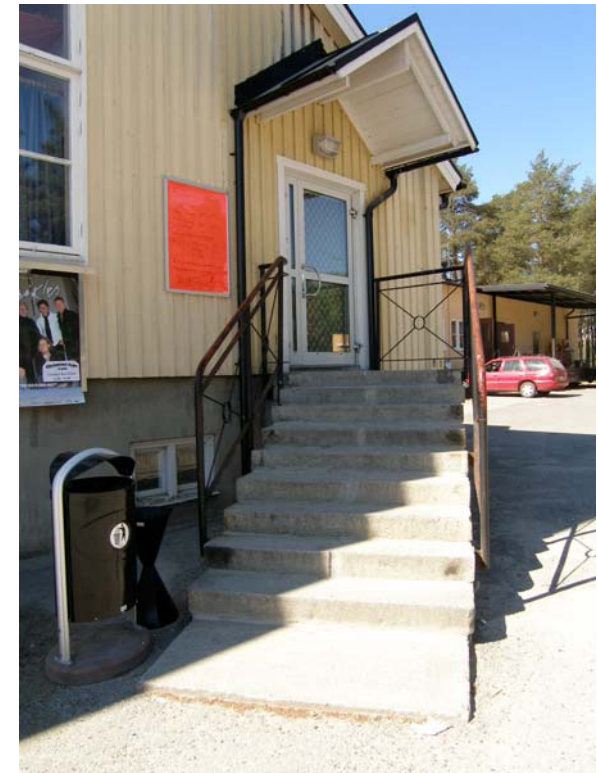
Trappa in till Nipanrestaurangen
