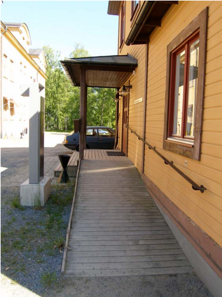
Ramp in till utbildningslokal vid Södra Kaserngården
