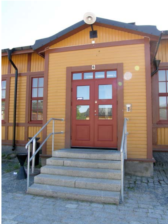
Trappa in till utbildningslokal vid Södra Kaserngården
