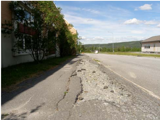
Trottoar intill Gudlav Bilder skolan
